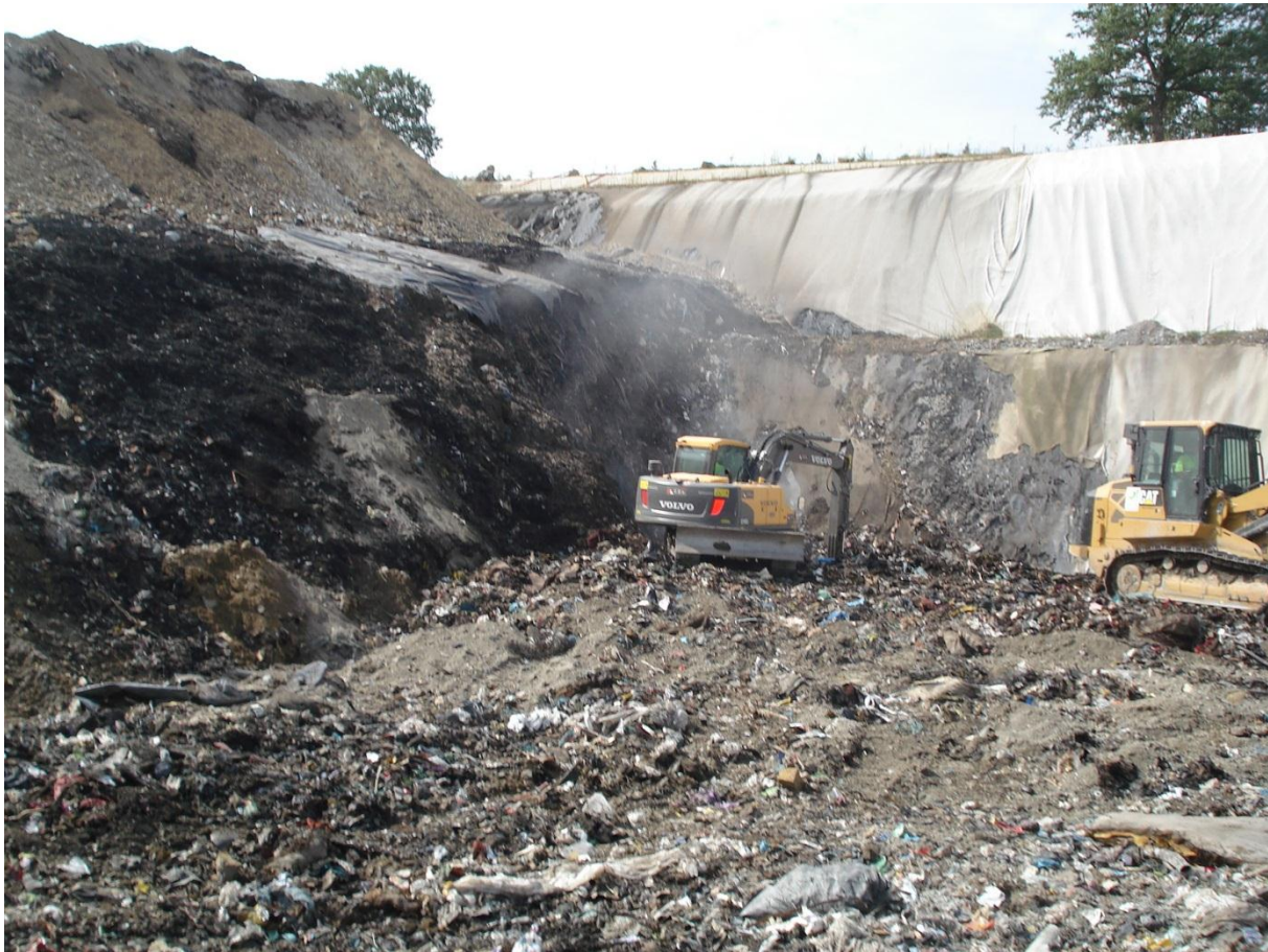
Endommagement de la géomembrane et du géotextile lors d'un incendie dans un centre de stockage de déchets (ARIA 42875)
